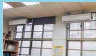
國小及幼兒園教室設置冷氣工程
