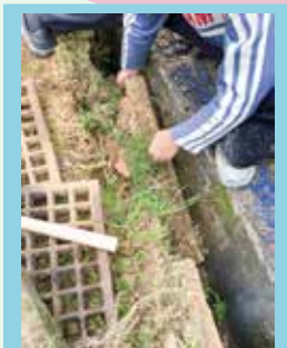
操場水溝修繕工程
