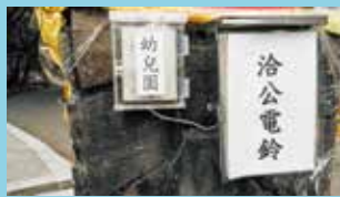
增設幼兒園大門對講機及螢幕設備
