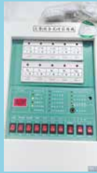
幼兒園教室照明設備更新
