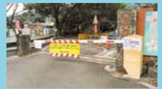
校園大門相關設施更新及維護改善工程
