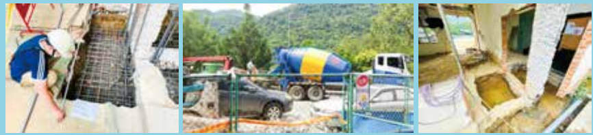
教學行政大樓耐震補強工程
