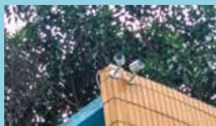
校園監視器設備增設與更新工程
